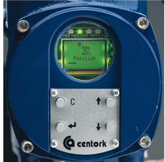
Permite un control digital continuo de la Posición de la válvula y del Par aplicado por el actuador con un ajuste no intrusivo de todos los parámetros.
